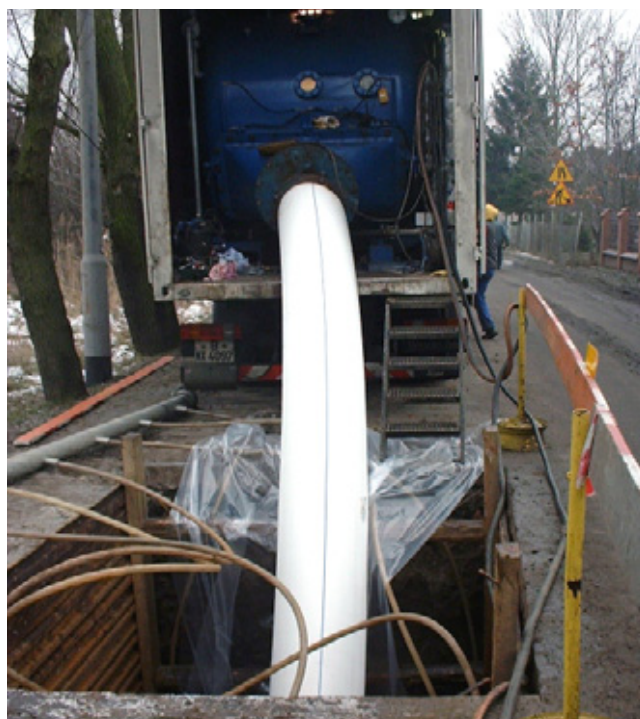
Fot. 3. Realizacja projektu Jastrzębie-Żory DN 600 – regenerowane odcinki o długości 200 m
