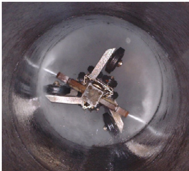
Fot. 1. Czyszczenie hydrodynamiczne metodą VACUJET – do metalicznego połysku (ciśnienie 1400 atm)
