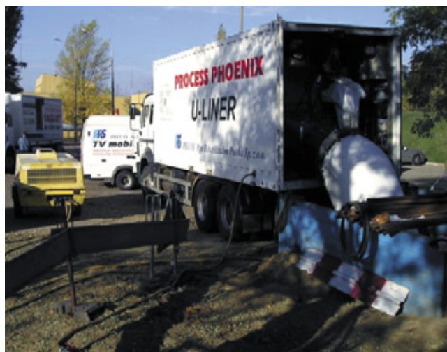
Fot. 2. Wprowadzanie rękawa Process Phoenix DN 1000
