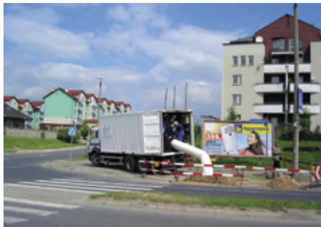
Fot. 2. Regeneracja przejścia syfonowego rurociągiem wody pitnej w Krakowie.
