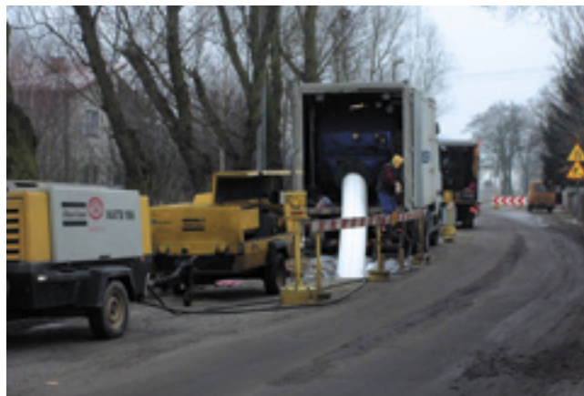
Fot. 1. Regeneracja rurociągu wody pitnej w Toruniu
